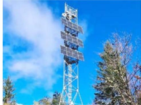
Le premier projet concerne le déploiement et la mise en service du **1<sup>er</sup> relais de transmission mobile « off-grid » (hors réseau électrique), alimenté à 100% avec des panneaux photovoltaïques.**
